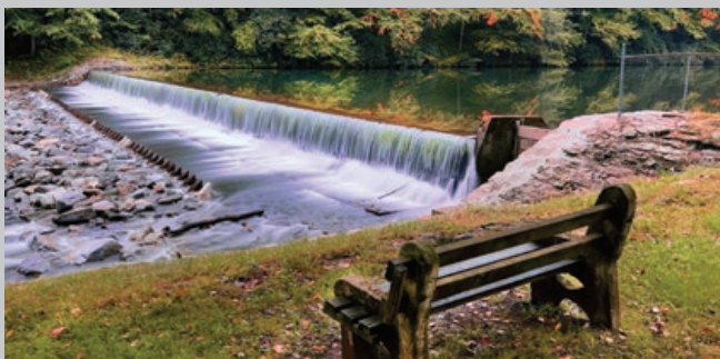
Vista de la presa en el área de camping de Kettle Creek, Parque Estatal de Kettle Creek, condado de Clinton.
