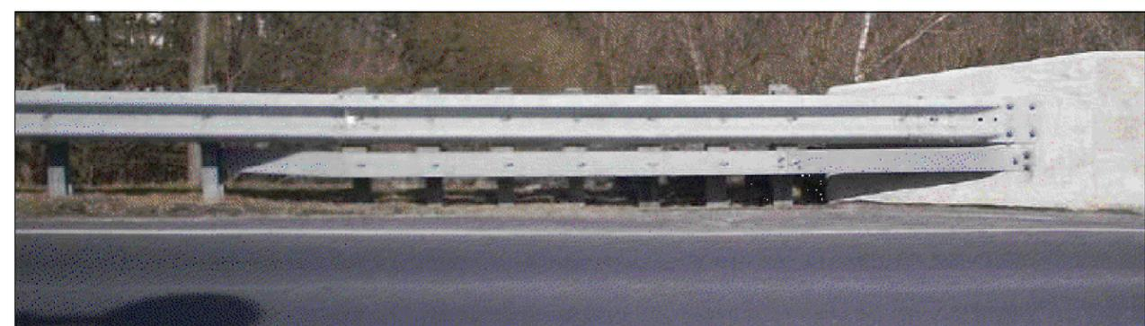
**ELEVATION VIEW FOR TYPICAL CONCRETE BRIDGE BARRIER TRANSITION**
